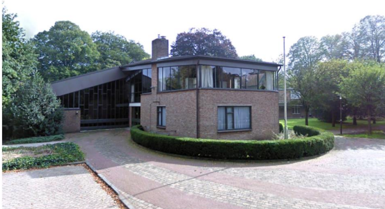
In tegenstelling tot eerdere berichten gaat de katholieke kerk in Nieuw-Schoonebeek toch dicht. Foto: Google Street View
